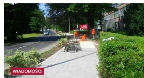
Remonty wrocławskich chodników
