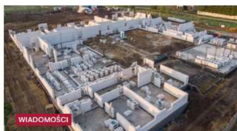
Budowa żłobka przy Sygnałowej
