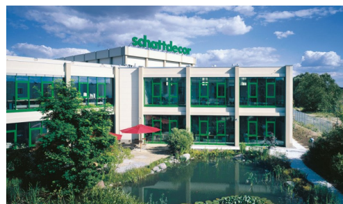
Centrala w Tarnowie Podgórnym
