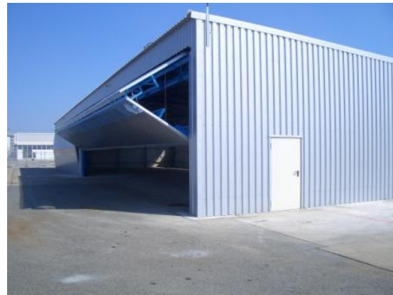
Flugzeughangar / Hangar lotniczy
